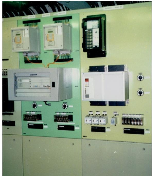
Bild 14 Schutz UW Rempendorf, Abg. Redwitz 253/254, Hauptschutz Distanzrelais PD551 mit AWE-Zusatz RM1-80, AEG und Reserveschutz Leitungsdiff. 7SD512 mit Signalübertragungsgerät SWT2000D, Siemens
