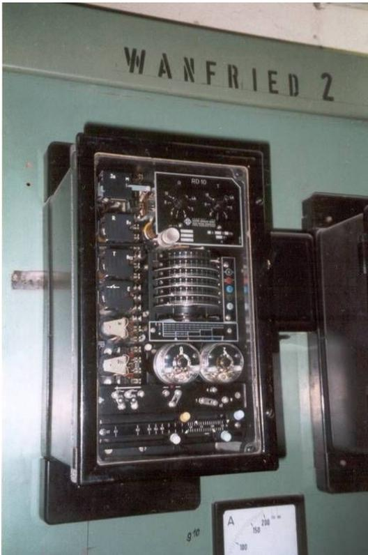
Bild 4 Distanzschutz RD10, EAW, UW Katharinenberg, 30-kV-Leitung Wanfried
