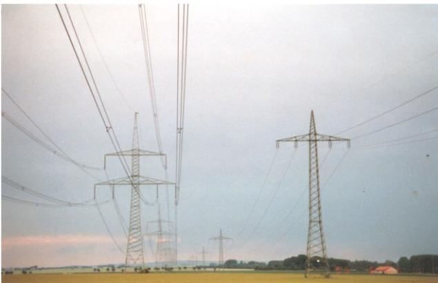
Bild 12 Leitungen der Wiedervereinigung, Nähe Gotha, 380 kV, 50 Hz und 110 kV, 16 2/3 Hz
